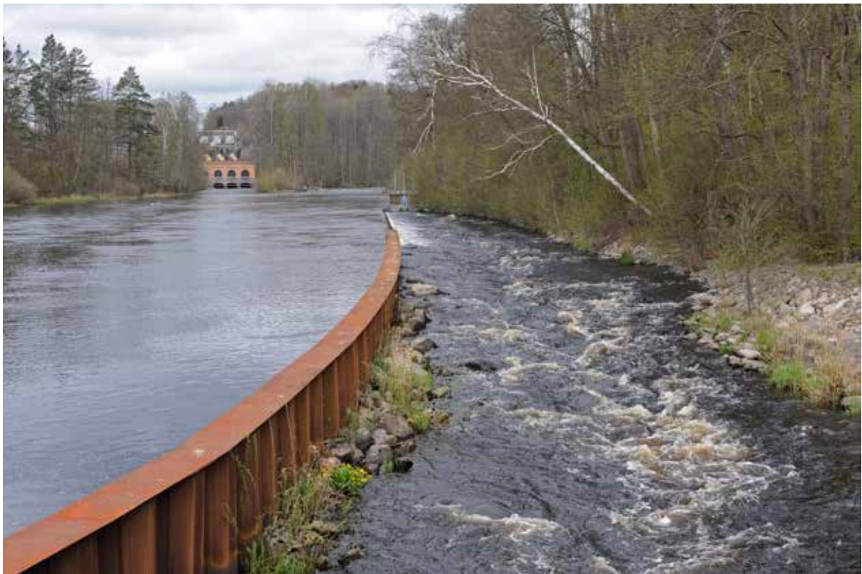
Figur 21. I Mörrumsån finns anlagda fiskvägar förbi de flesta kraftverken. Teknisk fiskväg i form av en slitsränna vid Marieberg (ovan; borttagen i samband med utrivningen av Mariebergs kraftverk sommaren 2020) och inlöp i form av en avskild sidofåra vid Hemsjö nedre (nedan).
