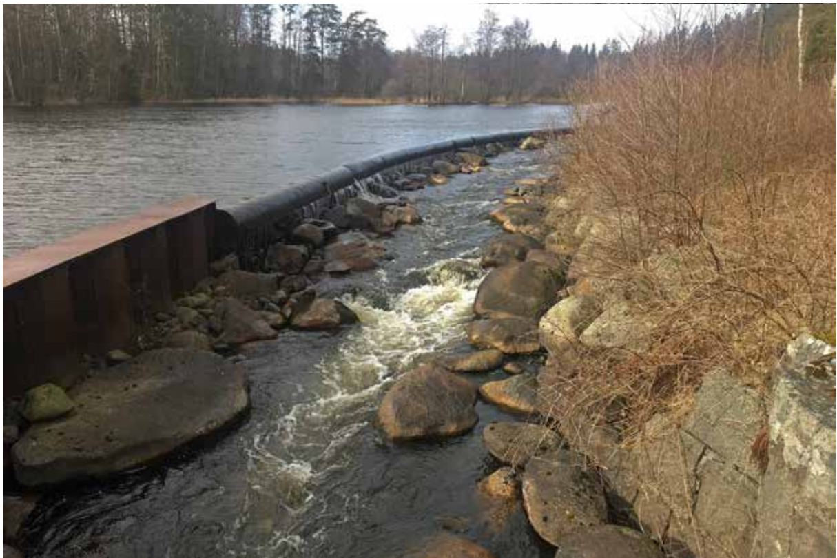
Figur 30. Skibord, det vill säga nivåreglerande konstruktioner, finns av flera olika slag. Vid Rosendala finns ett mycket stort skibord av tuktad sten som funktionsmässigt påminner om en stenkista (ovan), vid Hemsjö övre finns ett moderna överfallsvärn bestående av liggande betongrör på stålspont (nedan).
