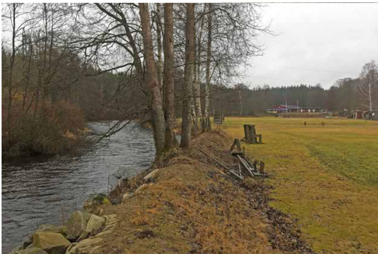
Figur 24. Invallningar har flera syften, förutom det uppenbara att skydda bebyggelse och strandnära anläggningar (ovan) kan det handla om att skapa raka och jämna stränder och förhindra vattnet att gå upp på angränsande låglänta partier.
