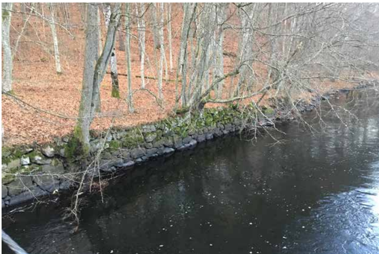
Figur 31. Modern strandskoning vid Fridafors nedre kraftstation (ovan) och en äldre kallmurad konstruktion vid Rosendala (nedan).
