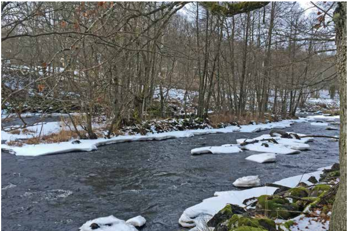
Figur 27. Ledarmar består av block och sten från rensade strömsträckor, upplagda så att man får ett rakt flöde med raka kanter. De är absolut vanligast i huvudfåran. Tydliga exempel finns vid Hönebygget (ovan) och Åkeholm (nedan).
