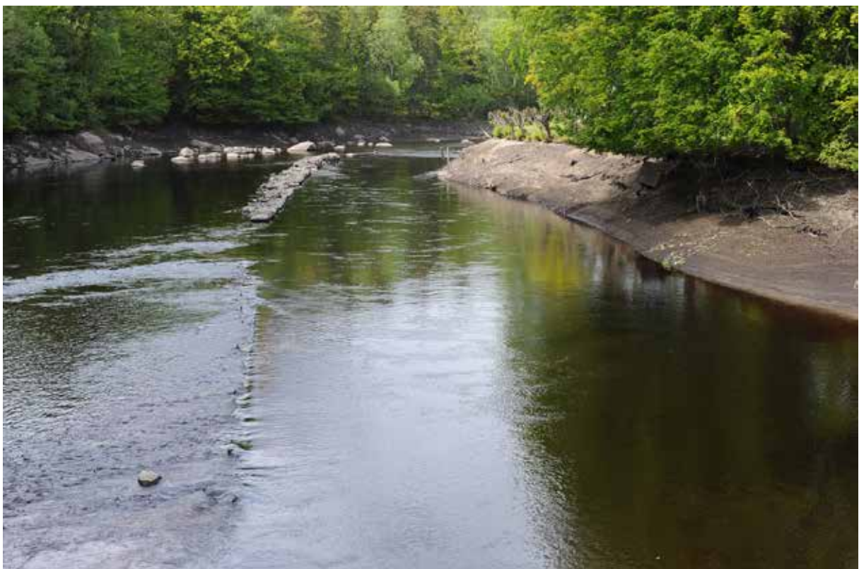
Figur 5. I samband med avsänkningen av dammen vid Mariebergs kraftverk våren 2020 blottades såväl orörda partier som de kallmurade ledarmarna till en gammal intagskanal. Foto: Mikael Svensson.
