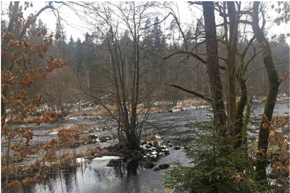
Figur 19. I Mörrumsån finns ett stort antal anläggningar för fasta fisken. Vissa konstruktioner som den vid Laxens hus i Mörrum är lätta att identifiera (ovan), medan andra som den vid Härnäs är svårare att tolka (nedan).
