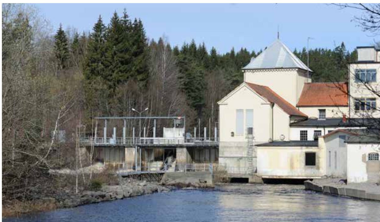
Mariebergs kraftverk före utrivningen, april 2020.
