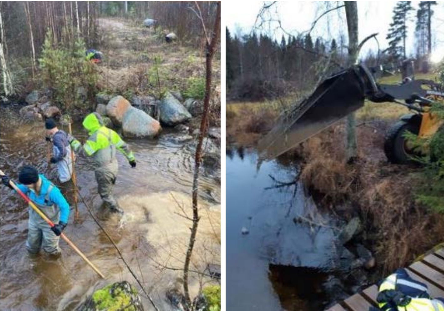
Laying of spawning gravel in Klintforsån, Skellefteå Västerbotten.
