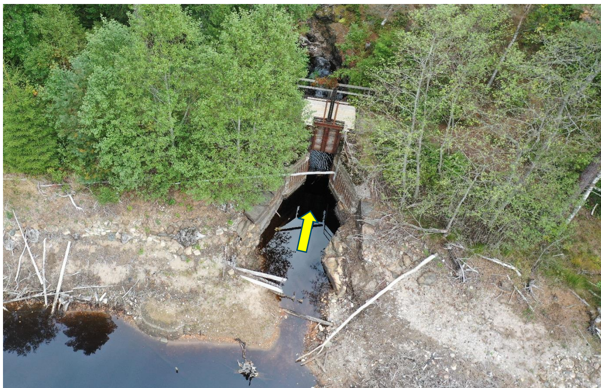
Figur 8.2. Regleringsdammen i Haraldsjöns utlopp.
