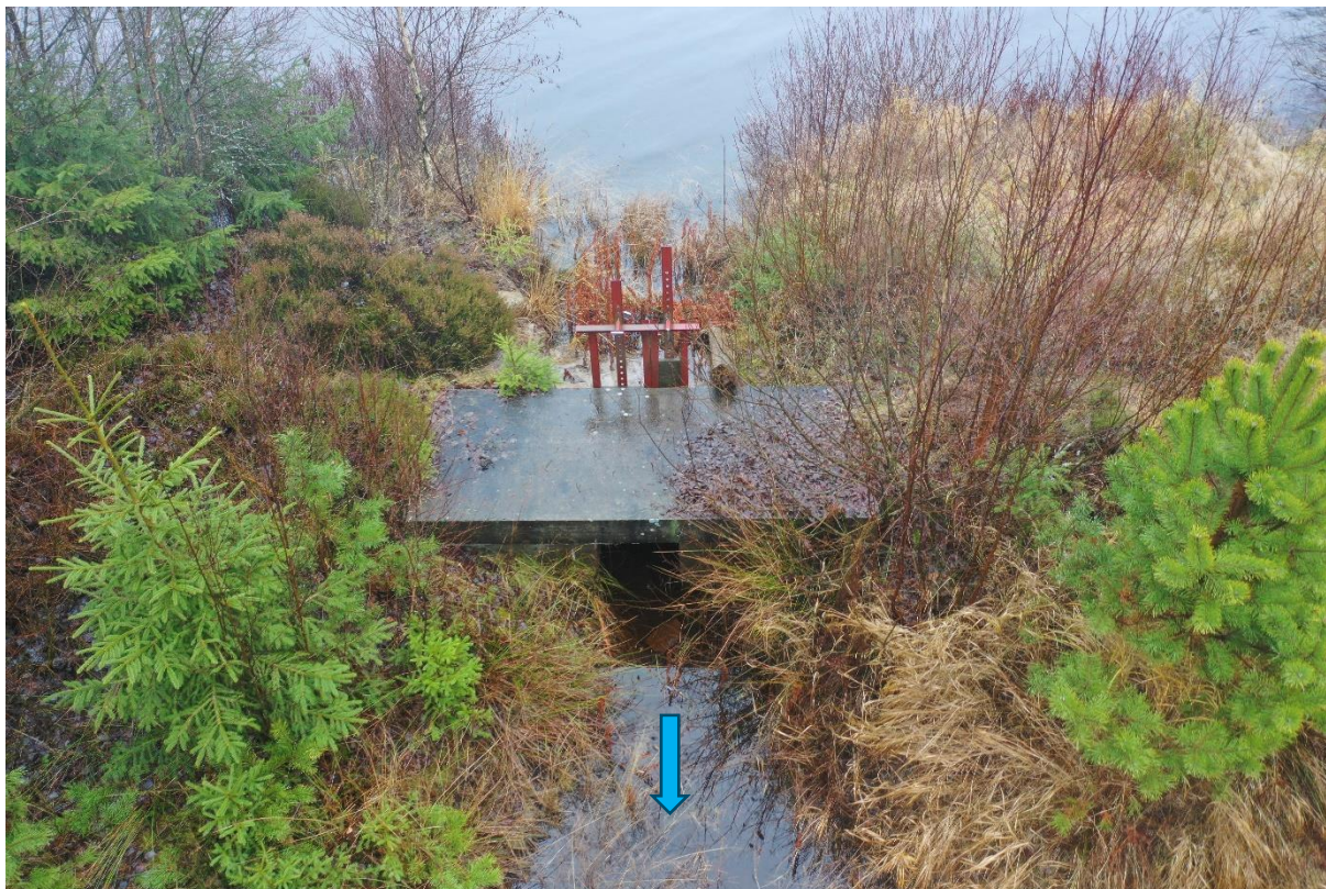
Figur 4.2. Reglerdamm i utloppet till faunapassagen sedd från nedströmssidan.
