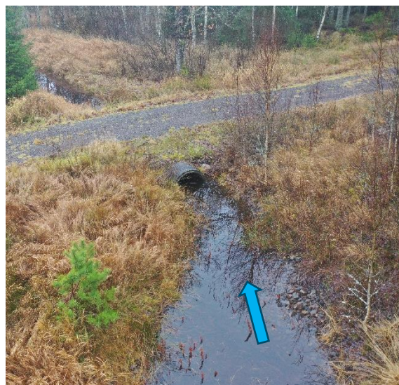
Figur 8.2. Till vänster: Reglerutskov i utloppet till faunapassagen samt betongbro. Till höger: Vågtrumma i faunapassagen.
