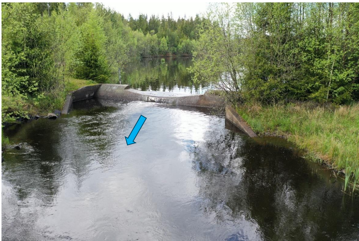
Figur 8.1. Överfallsdammen i Linnebjörkesjöns utlopp sedd från nedströmssidan.
